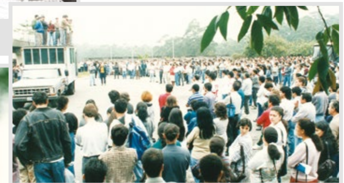
1995 - CBC - Explosão mata trabalhador. Foto: Roberto Parizotti
